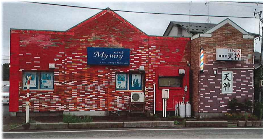
国道に面して建っている外観、スナック(左)と理容室(右)
