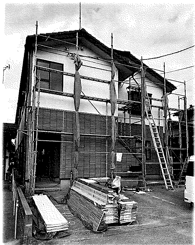
外壁材の施工
