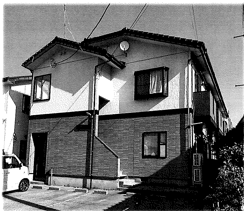
外壁工事完了後の建物
